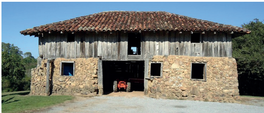
Figura 7 – Casa de pedra edificada por Giusto Casarin em 1888. Fonte: autores (2010).
