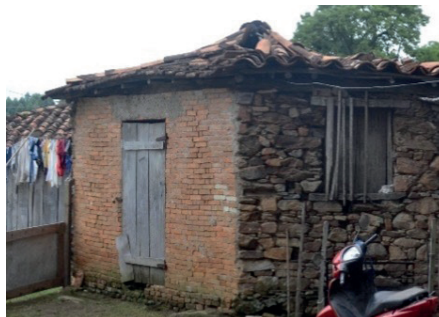
Figura 4 – Porta e postigo da casa Formentin. Fonte: autores (2022).
